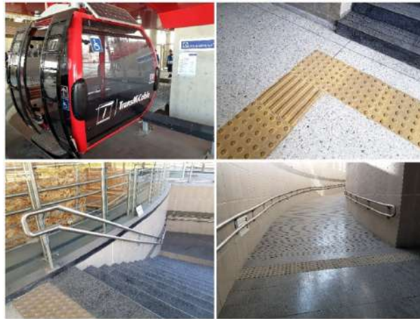
Ajustes técnicos de accesibilidad en el sistema TranmiCable
